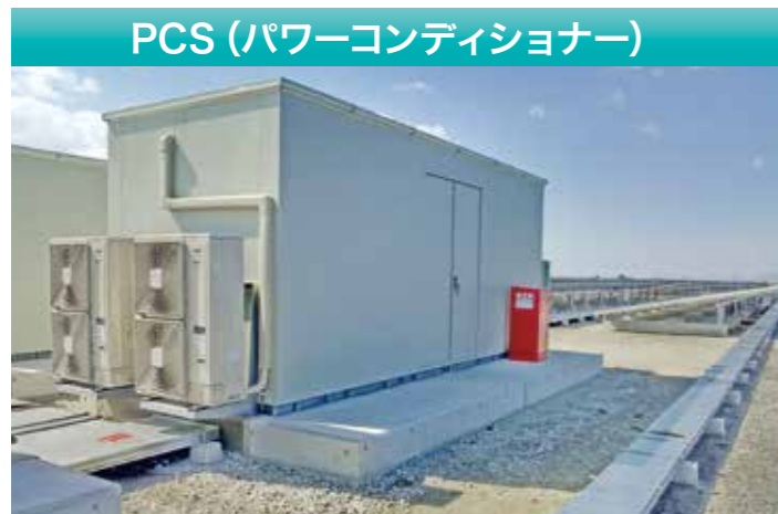
太陽電池の直流電力を交流電力に変換して供給する電源装置
