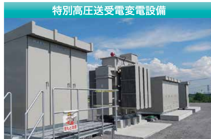
発電した電力を発電所から電力会社へ送電する設備
