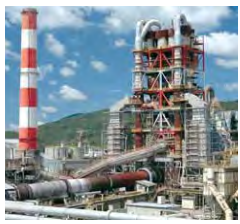
▲セメント製造施設
