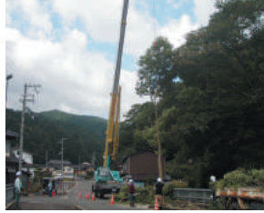
クレーンを用いて人家裏山の危険木を伐採
