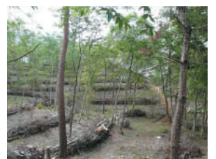
荒廃した広葉樹林を間伐し、土留工を設置
