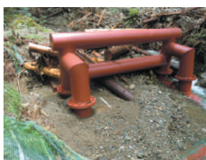
流木を受け止める簡易流木止め施設
