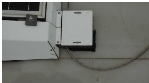
三木北高等学校の架台設置角マーキング
