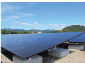
▲西脇市太陽光発電所 市制10周年となる2015年に完成し、稼働を開始しました。約18,200㎡の土地に8,224枚のパネルが設置され、年間約144万kWhの発電を行っています。
