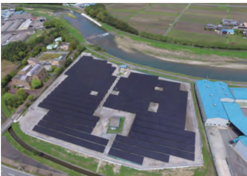
▲西脇市太陽光発電所 市制10周年となる2015年に完成し、稼働を開始しました。約18,200㎡の土地に8,224枚のパネルが設置され、年間約144万kWhの発電を行っています。
