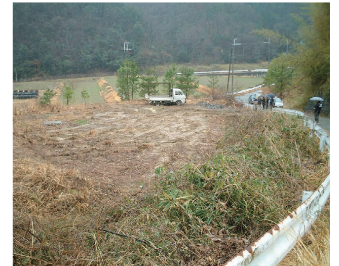
廃棄物撤去後(2005年、安富町)
