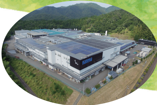
▲工場全景とZEB化を実現した事務所棟(写真右奥)
